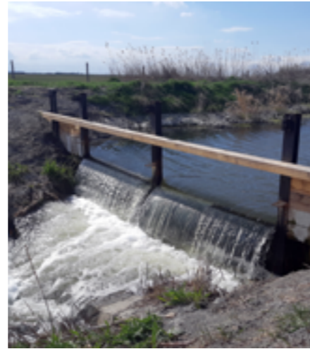
Betétpallós ideiglenes gát duzzasztja vissza a Csukás-éri-főcsatorna vizét, ami így eljut a Sós-tóba. Fotó: Kiss Mónika
