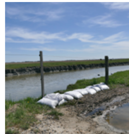
Homokszákokkal akadályoztuk meg, hogy a víz visszafolyjon a gyepről a csatornába. Fotó: Kiss Mónika
