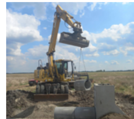
Zsilipes átterest építés közben Fotó: Pataki Zsolt
